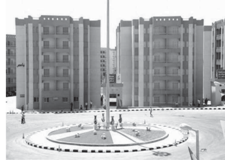
2.5 مليون وحدة سكنية كاملة المرافق
