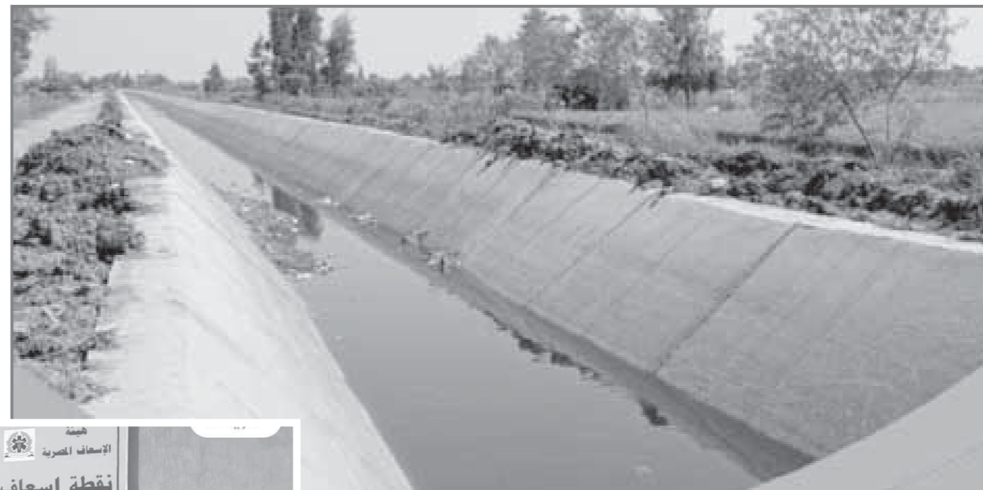
مشروع تبطين الترع يتم بشكل متوازى فى جميع المحافظات
