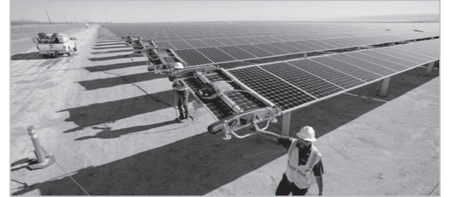
إنشاء محطات توليد الكهرباء المتجددة
